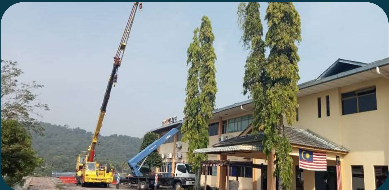
Foto 6.3 Aktiviti penyelenggaraan bangunan dan baik pulih bumbung lama
