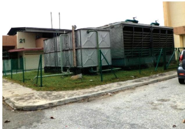
Foto 10.3: Menaiktaraf sistem penyejukan sekunder Reaktor TRIGA PUSPATI (RTP) dilaksanakan dari RMK10 dan dijangka tamat dalam RMK11
