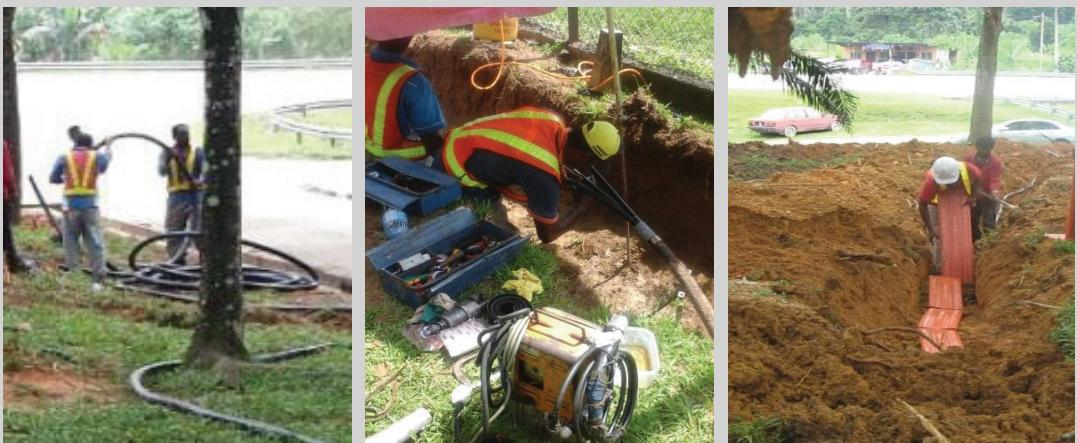
Kerja-kerja penggantian High Voltage (HV) kabel di Kompleks Dengkil
