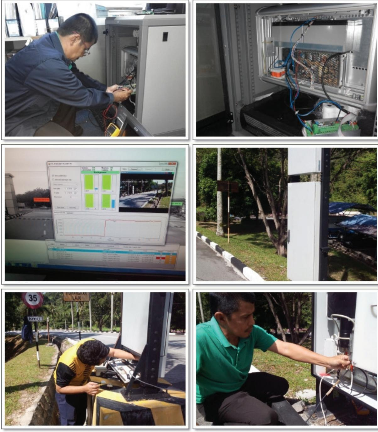
Foto 10.17: Penyenggaraan sistem pemantauan akses bahan nuklear dan radioaktif di pintu masuk utama Nuklear Malaysia
