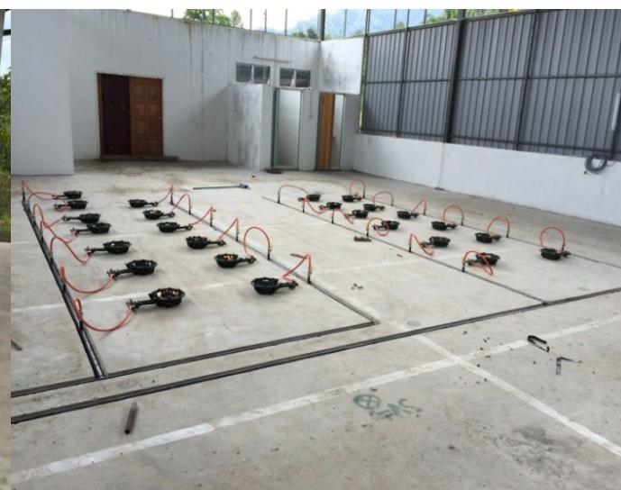
Foto 9.26 Sistem gas (paip gas dan tong gas LPG) dan kerja pemasangan sistem paip gas untuk kemudahan ekstraksi minyak gaharu.
