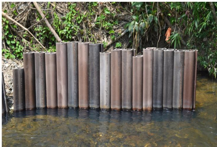
Foto 9.7 Kaedah pemasangan "RiverProtec" menggunakan sistem penyumbat penetap memanca.
