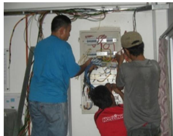
Foto 10.3 Pendawaian dan pemasangan papan agihan elektrik di bangunan reaktor
