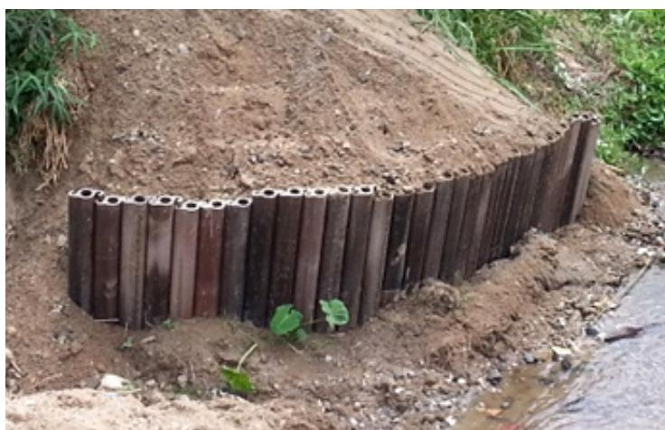
Foto 9.8 Pemasangan "RiverProtec" secara sistem penyumbat penetap mengufuk di tebing sungai.
