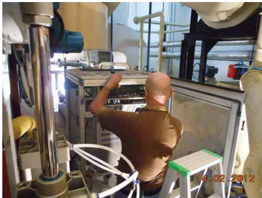
Foto 11.14: Pemasangan sistem pemonitoran pelepasan udara RTP
