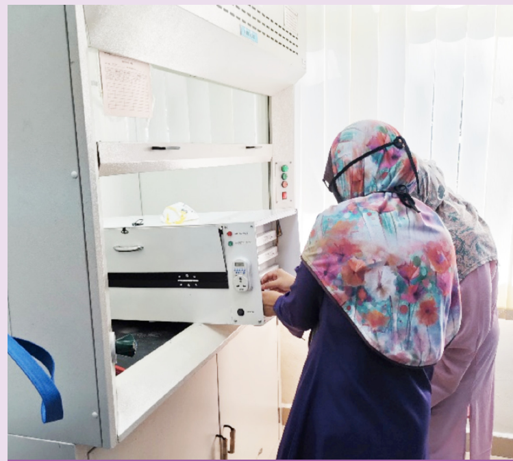
Foto 4: Kerja pembetulan litar elektrik yang bermasalah pada salah satu peti UVGI
