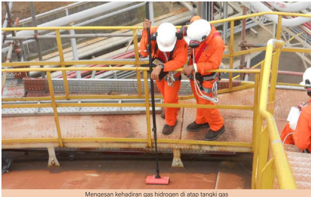
Mengesan kehadiran gas hidrogen di atap tangki gas
