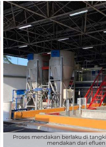
Proses rawatan efluen di LLETP bermula dari tangki pengumpul di sebelah kanan dan seterusnya efluen dicampur dengan bahan kimia rawatan di dalam tangki pencampur di sebelah kiri
