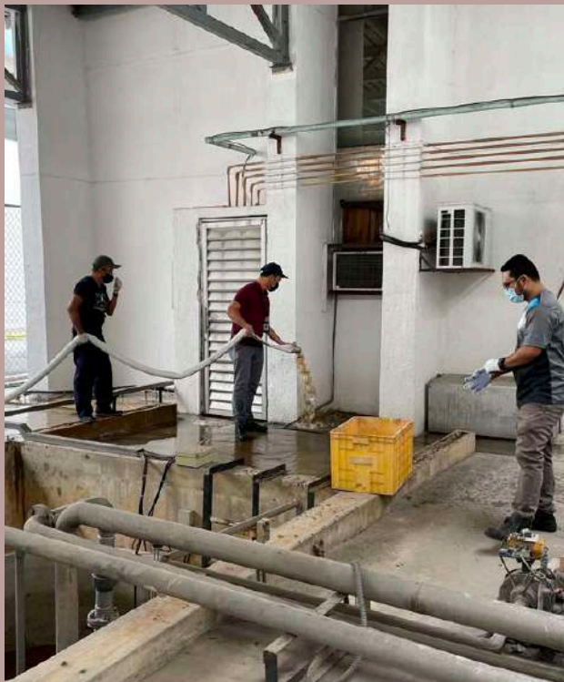
Penyenggaraan fasiliti sentiasa dilakukan bagi menjamin tahap keselamatan ruang pekerjaan
