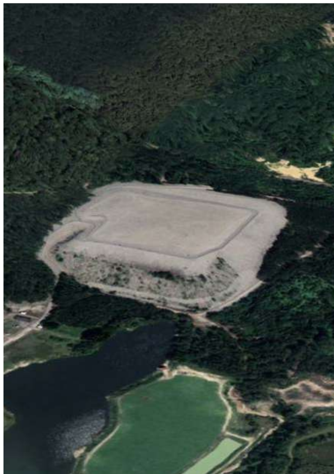
Repositori sisa torium Asian Rare Earth (ARE) di Mukim Belanja, Perak Sumber: Google Earth
