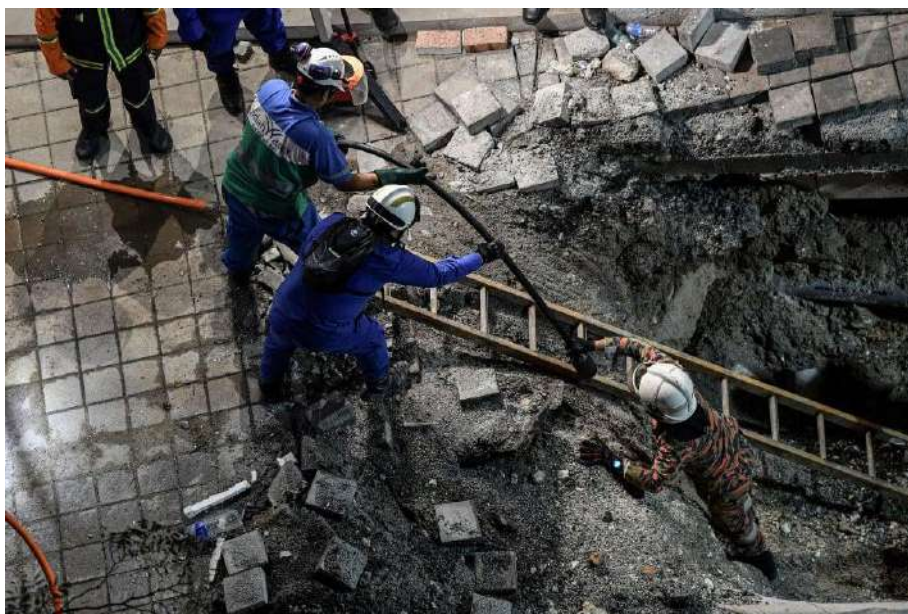
Petugas IWK dan anggota bomba menggunakan jentera mesin jetter atau jet pembersih berkuasa tinggi bagi memecah sisa batuan yang terdapat di lokasi kejadian dalam operasi mencari dan menyelamatkan (SAR) wanita warga India yang hilang dalam insiden tanah jerlus di Jalan Masjid India semalam.
