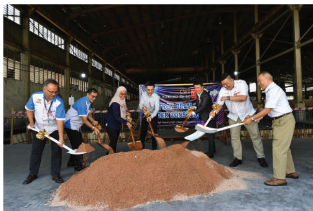
Majlis Pecah Tanah Pembangunan Projek E-Beam (Alor Gajah, Melaka)
